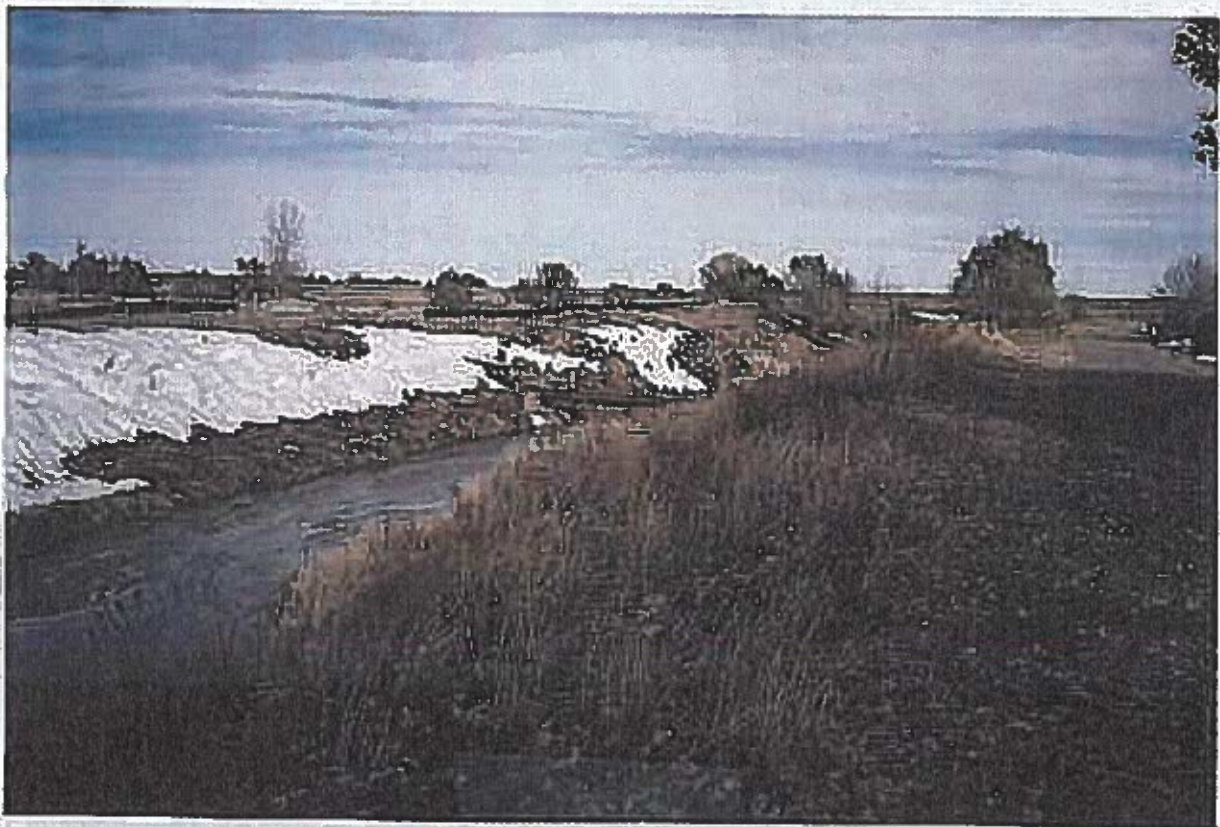
East Fork, Sand Creek - 11/3/97 Sta. 43+00+/- Existing Conduit
